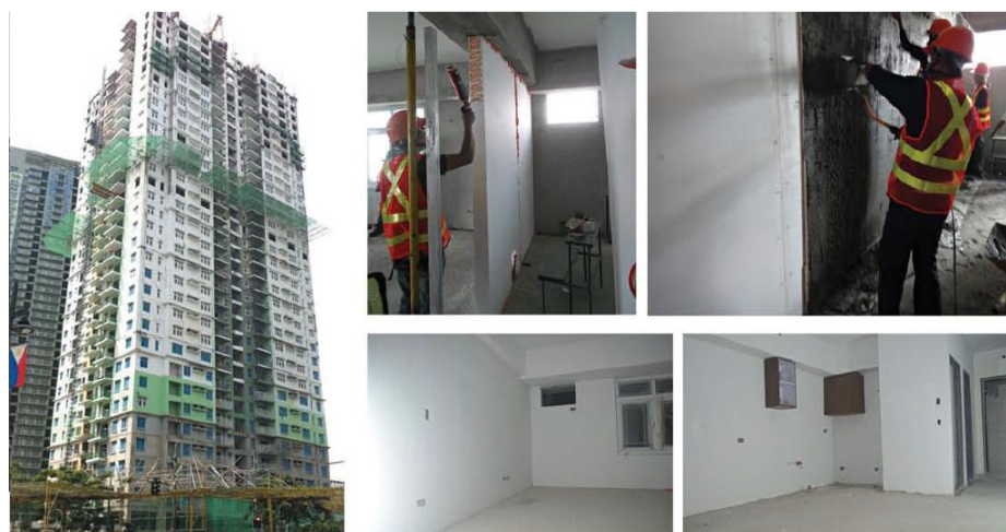
شکل ۳: نمونه از اجرای ساختمان های بلندمرتبه با المانهای غیرسازه ای MAS - شهر Taguig، فیلیپین
