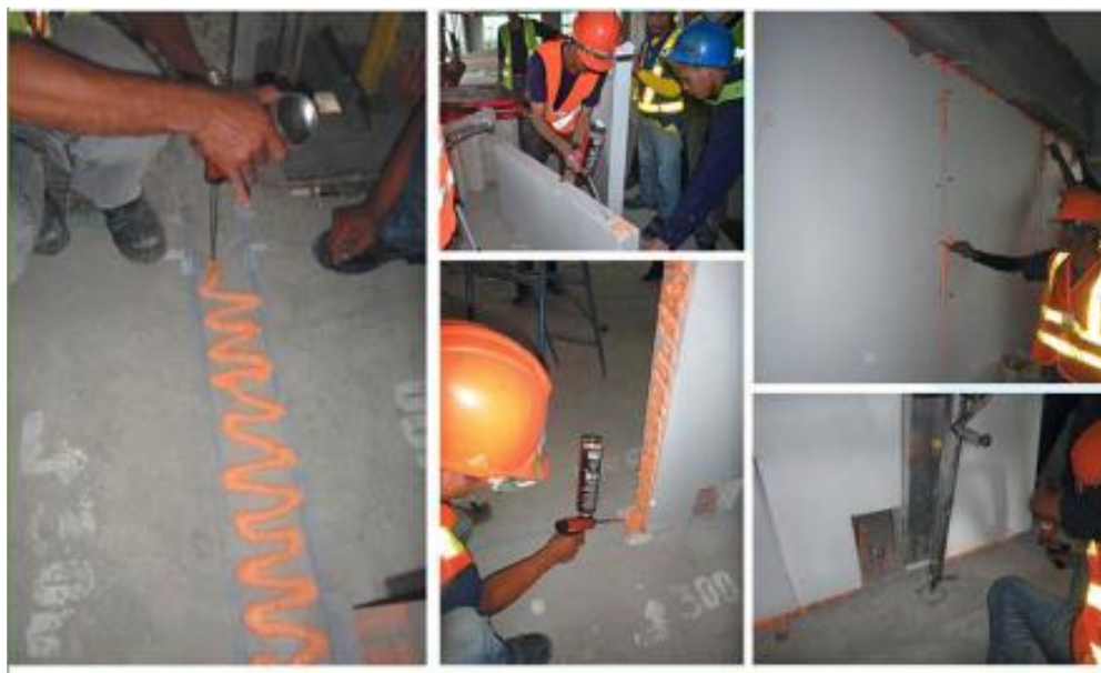
شکل ۴: اجرای دیوارهای MAS با چسب مخصوص
