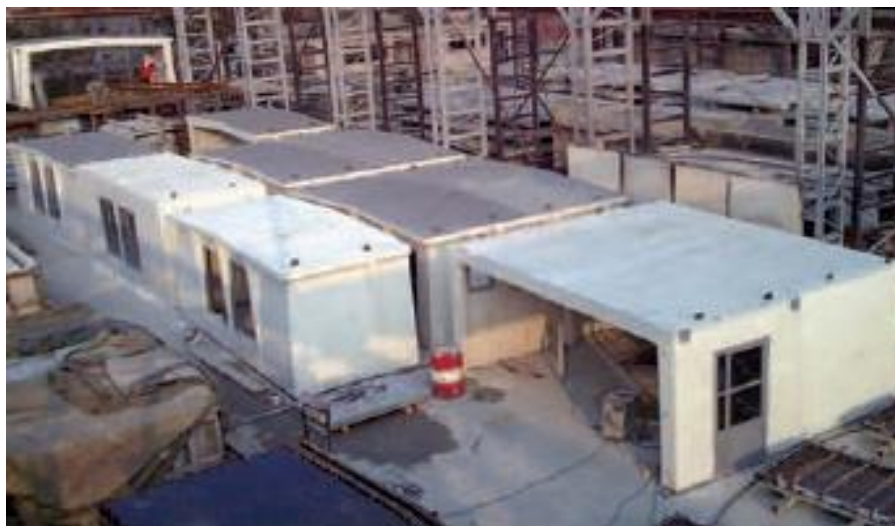
شکل ۲-۷۴: اجرای سیستم پیش ساخته D۳
