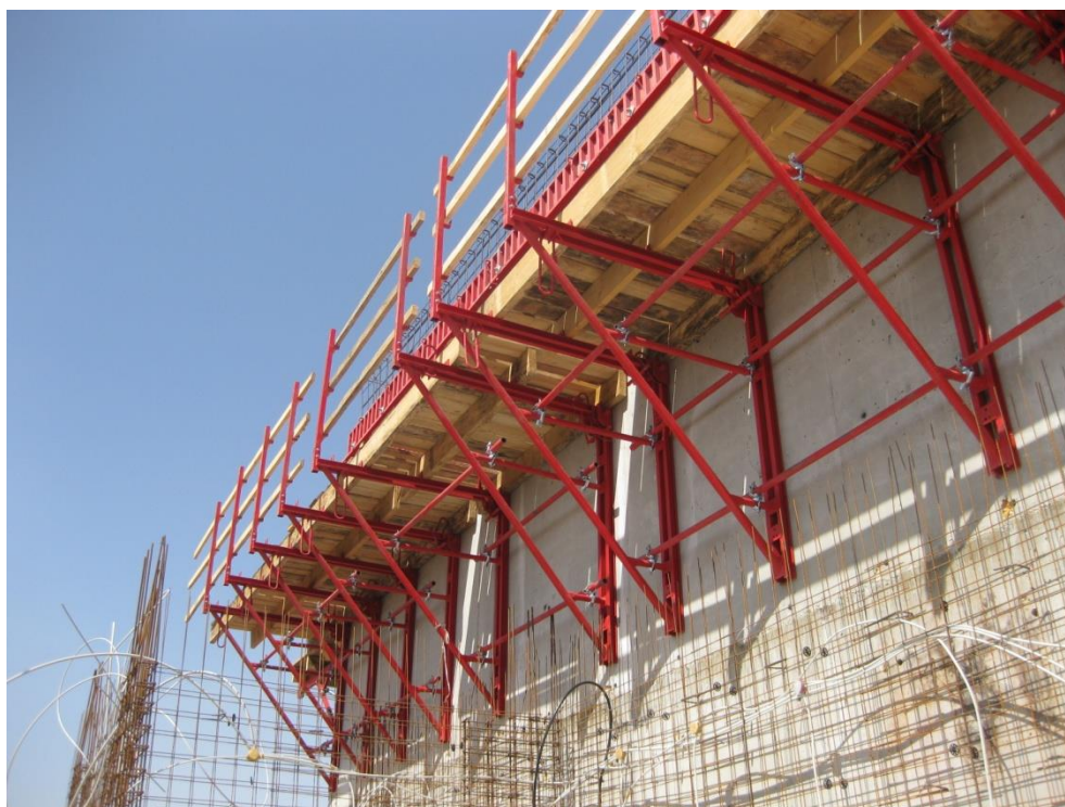
شکل ۲-۳۳: قالب بندی کف و دیواره جانپناه به منظور فراهم نمودن فضای کار در دیوارهای پیرامونیدر سیستم قالب تونلی
