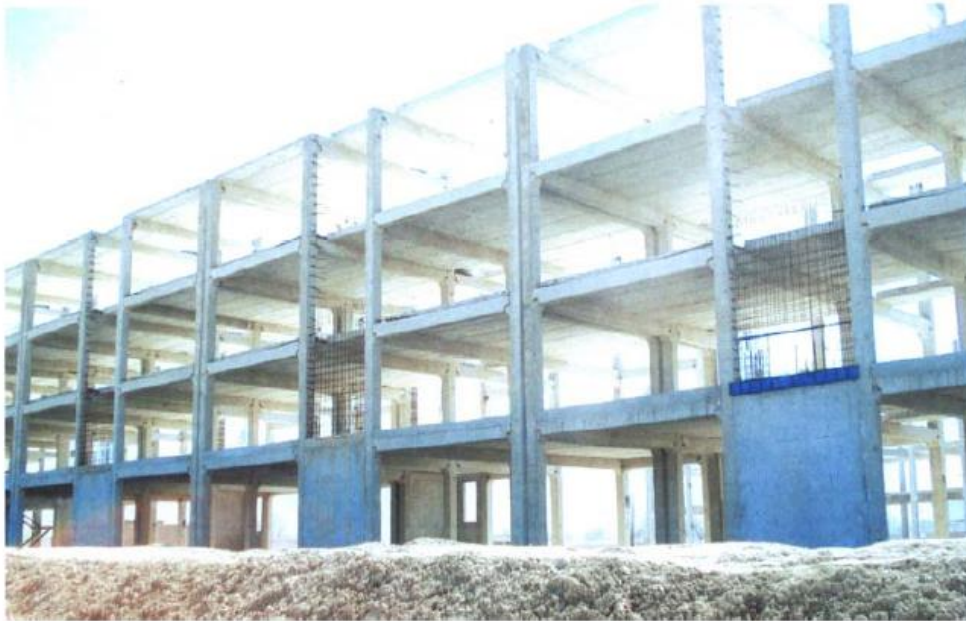
شکل ۲-۶۸: اجرای دیوارهای برشی بصورت درجا در سیستم پیش ساخته
