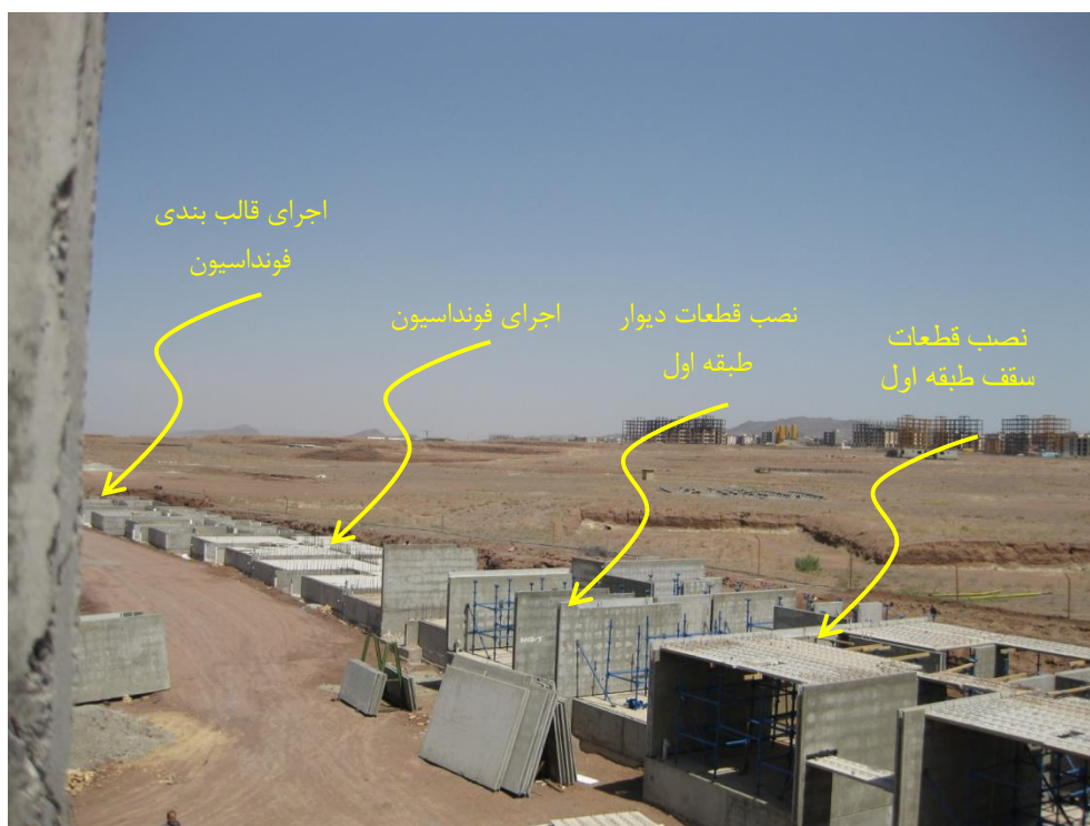
شکل ۲-۴۳: مراحل متنوع عملیات اجرایی کارگاهی در سیستم نیمه پیش ساخته با دیوار دو لایه
