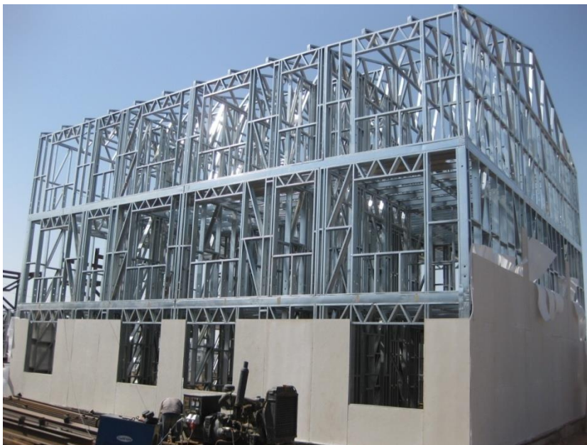
شکل ۱-۲: اجرای ساختمان ۳ طبقه با سیستم LSF
