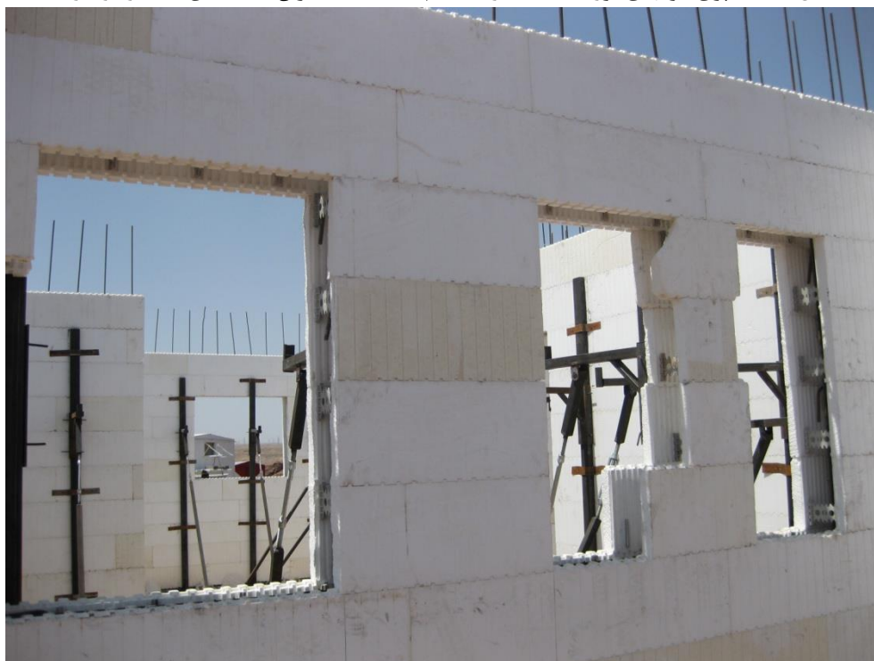
شکل ۲-۲۲: نصب بلوکهای سیستم H-ICF با لحاظ نمودن محل بازشوها و مطابق با نقشه
