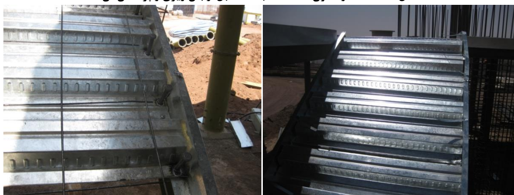
شکل ۲-۸۵: نحوه اجرای راه پله توسط سیستم دال عرشه مرکب قبل و پس از میلگرد گذاری
