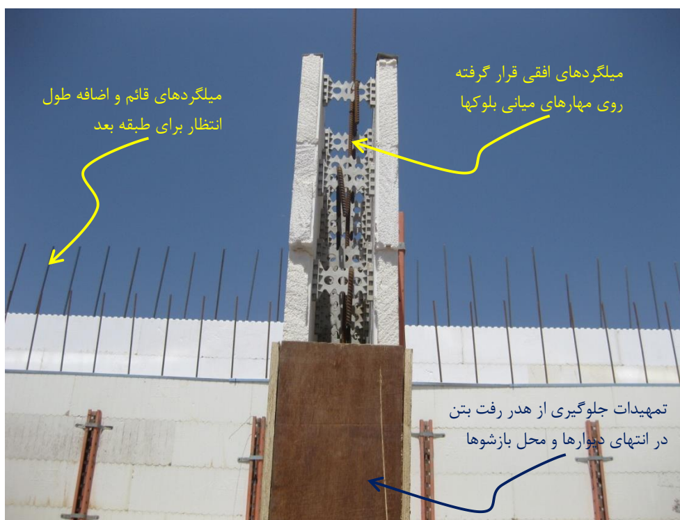
شکل ۲-۲۴: میلگرد گذاری در بین بلوکهای نصب شده سیستم H-ICF با لحاظ نمودن میزان طول انتظار برای طبقات بعد
