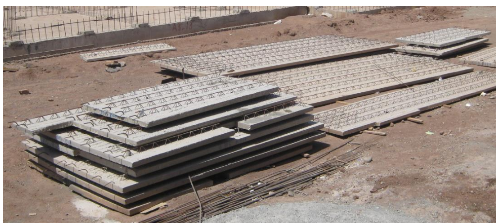
شکل ۲-۴۲: دپوی قطعات ساخته شده نیمه پیش ساخته حمل شده از کارخانه در کارگاه ساختمانی
