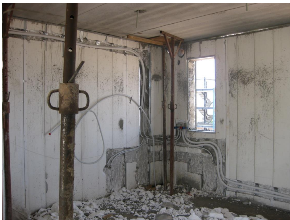
شکل ۲-۱۹: نحوه اجرای تاسیسات زیربنایی مکانیکی از جمله لوله کشی سرد و گرم در مرحله سفت کاری در سیستم V-ICF
