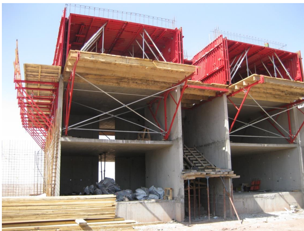
شکل ۲-۳۴: قالب بندی دیوارها و سقفها در سیستم قالب تونلی و آماده سازی برای بتن ریزی
