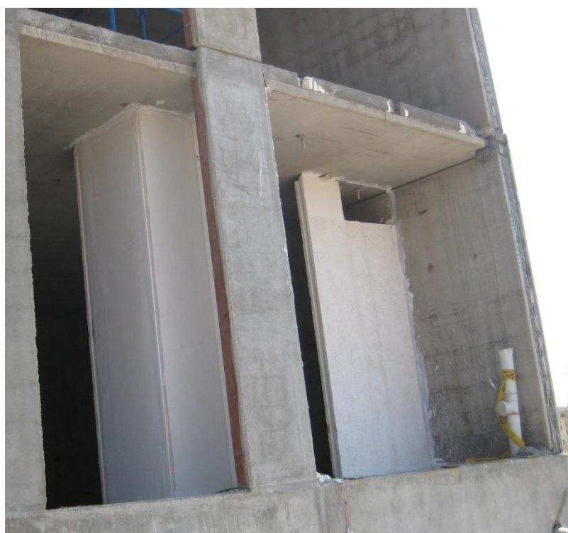
شکل ۲-۴۹: اجرای تیغه های جداکننده از انواع مختلف ( در ساختمان مورد بررسی از پانلهای گچی می باشد) در سیستم نیمه پیش ساخته با دیوار دو لایه
