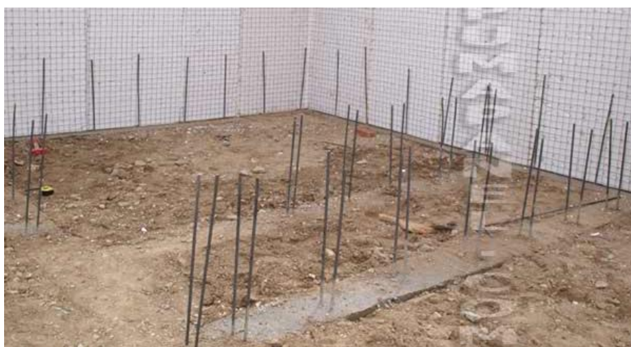
شکل ۲-۸۶: نحوه اجرای فونداسیون و آرماتورهای انتظار
