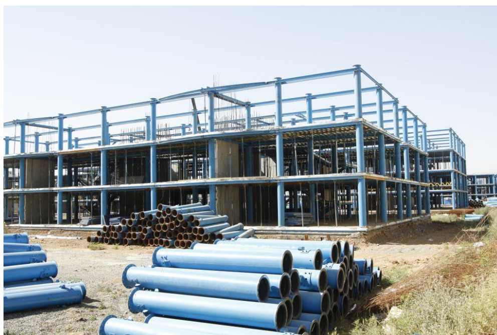
شکل ۷۹-۲: نمونه ساختمان در حال ساخت با سیستم ستونهای CFT و سقف دال عرشه مرکب
