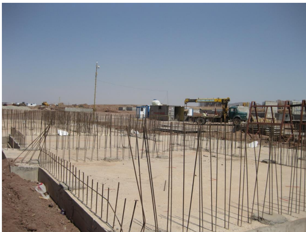
شکل ۲-۴۱: اجرای فونداسیون گسترده به همراه میلگرد انتظار در سیستم نیمه پیش ساخته با دیوار دولایه
