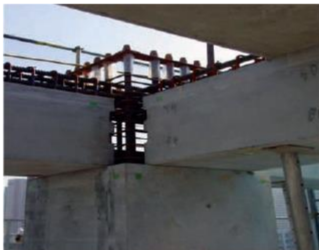
شکل ۲-۷۵: اتصال غلافی در فناوری R-PC
