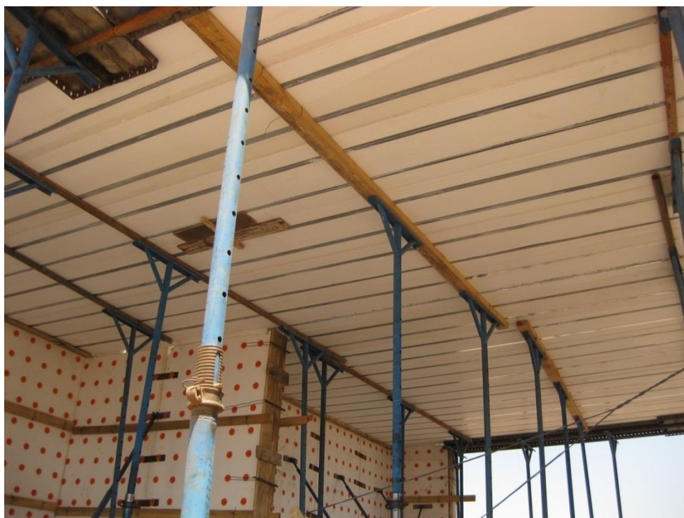
شکل ۲-۵۴: سقف ساخته شده از المانهای عایق طولی حاوی مسلح کننده های ناودانی شکل گالوانیزه به منظور حذف و کاهش قابل ملاحظه تعداد جکهای نگهدارنده سقف قبل از بتن ریزی
