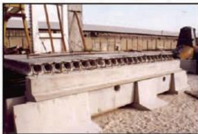
شکل ۲-۷۳: سیستم سقف پیش ساخته با هسته توخالی ((Hollow Core
