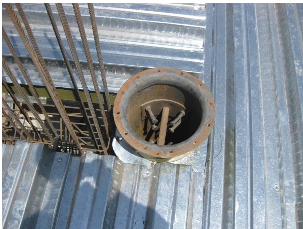
شکل ۲-۸۴: نما از ستون CFT نصب شده قبل از بتن ریزی و پر شدن آن
