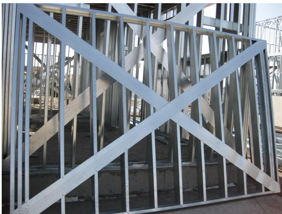
شکل ۲-۶: ایجاد مقاومت در برابر بار جانبی به کمک تعبیه عناصر قطری (بادبندی) در سیستم LSF
