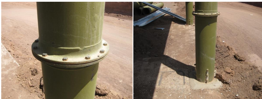
شکل ۲-۸۰: نمونه اتصالات پای ستون و وصله ستونهای CFT
