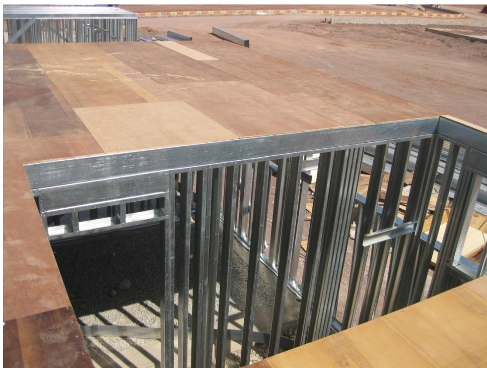
شکل ۷-۲: ایجاد پوشش اصلی سقف به کمک صفحات Plywood در سیستم LSF
