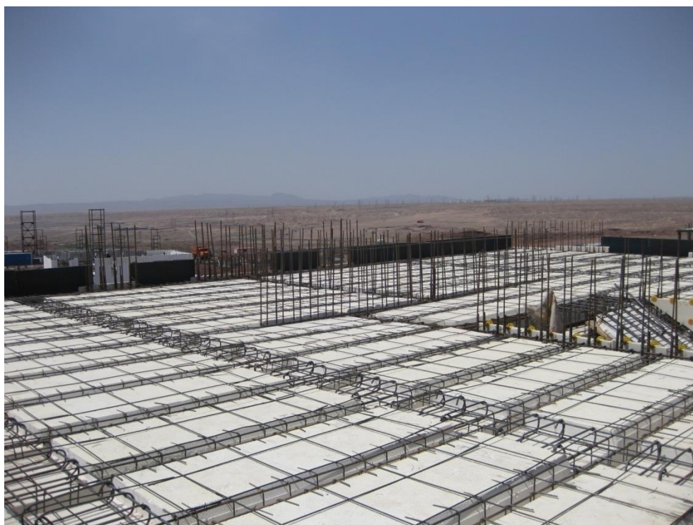
شکل ۲-۵۷: سقف آماده شده برای بتن ریزی پس از نصب المانهای عایق سقف در سیستم دیوار باربر با قالب عایق ماندگار پانلی
