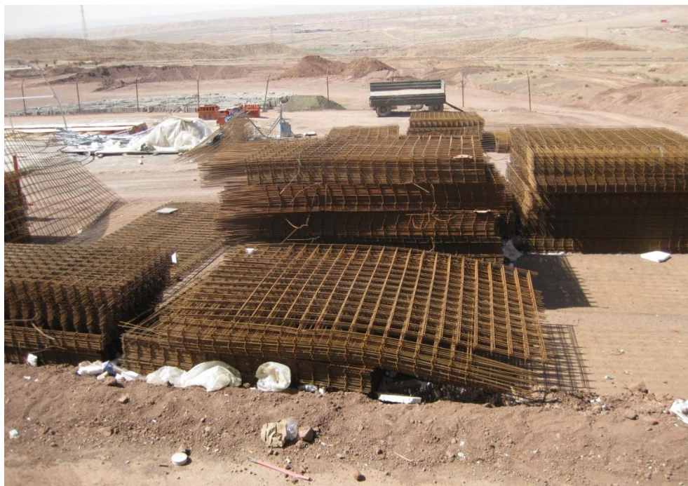
شکل ۲-۳۵: صفحات مش آماده شده از قبل از میلگرد برای تسریع عملیات اجرای میلگرد گذاری دیوارها و سقفها در سیستم قالب تونلی
