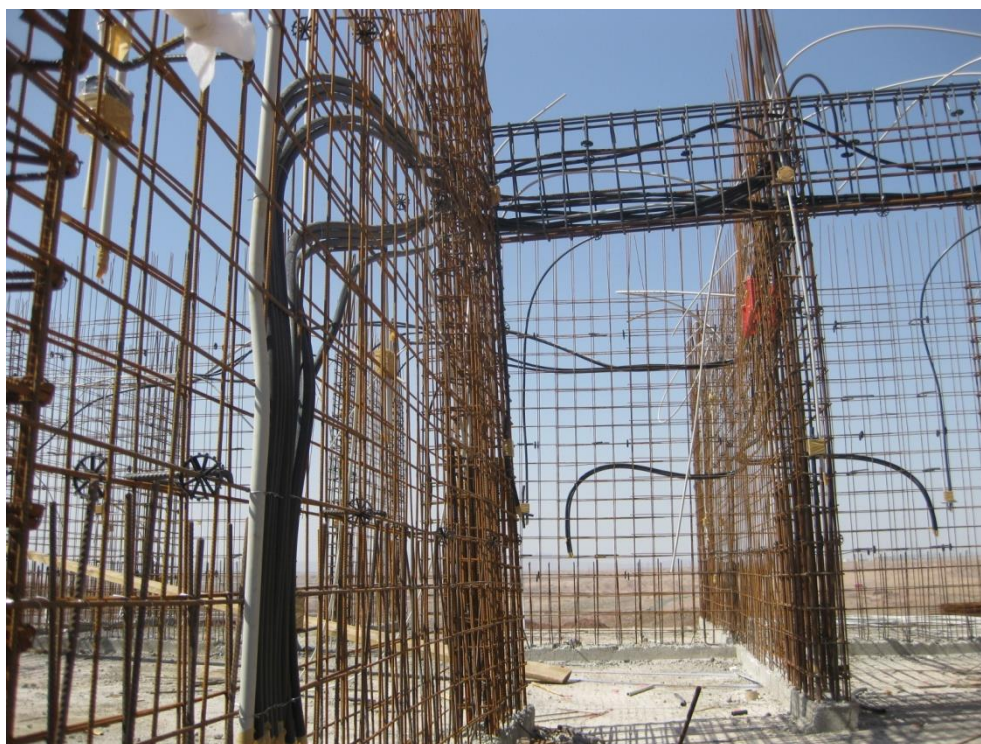
شکل ۲-۳۱: اجرای مقدمات تاسیسات برقی در داخل دیوارها و در بین میلگردها قبل از قالب بندی دیوارها
