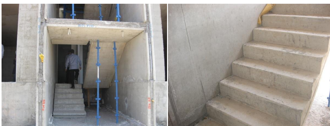
شکل ۲-۴۶: اجرای پله به صورت پیش ساخته در سیستم نیمه پیش ساخته با دیوار دو لایه
