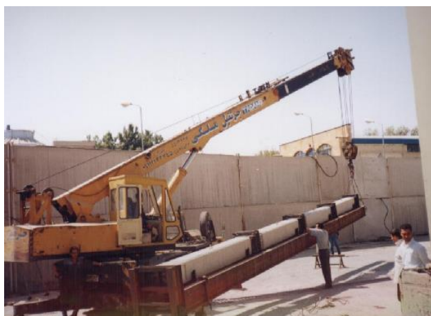
شکل ۲-۵۸: ستون پیش ساخته آماده شده برای نصب
