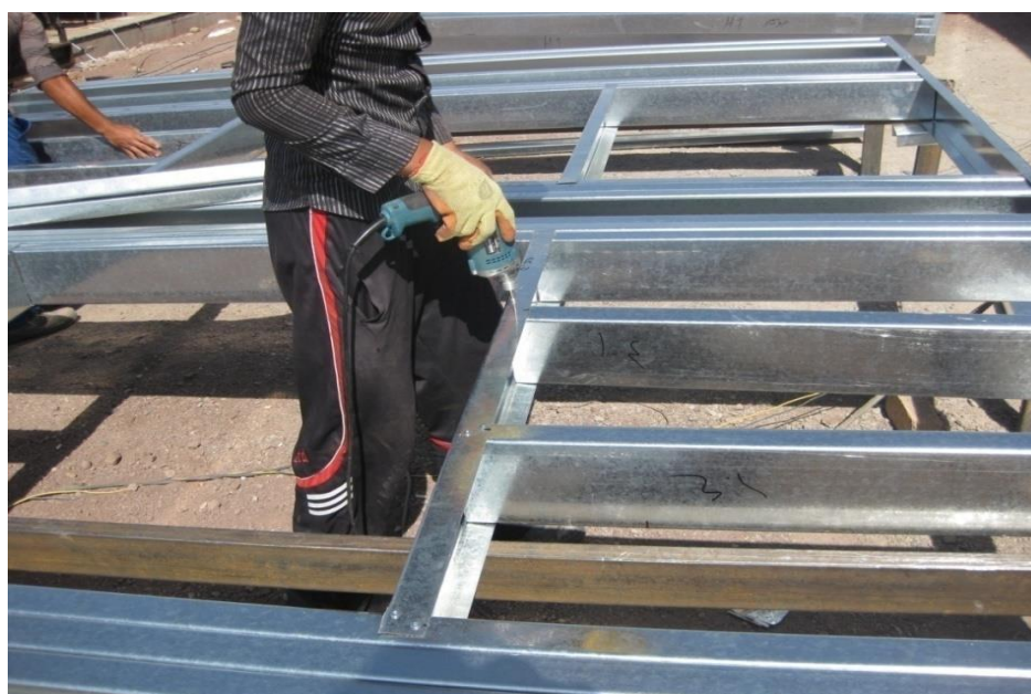
شکل ۲-۲: ساخت و سر همبندی رانر و استاد های سیستم LSF در محل کارگاه
