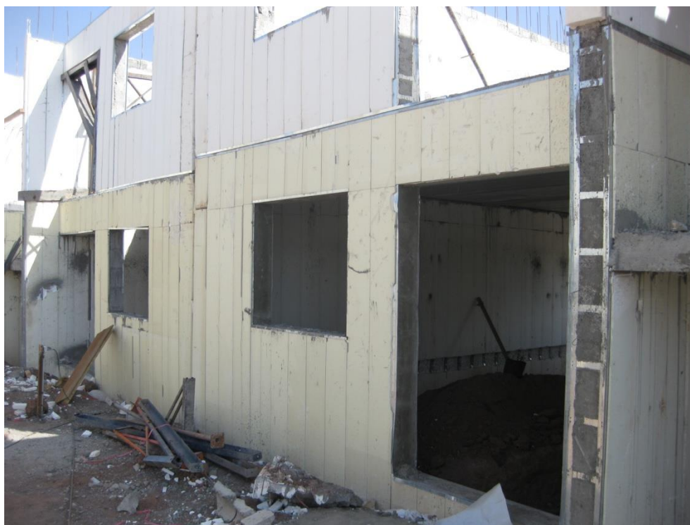
شکل ۱۲-۲: سازه سیستم V-ICF پس از بتن ریزی و باز شدن جکهای نگهدارنده
