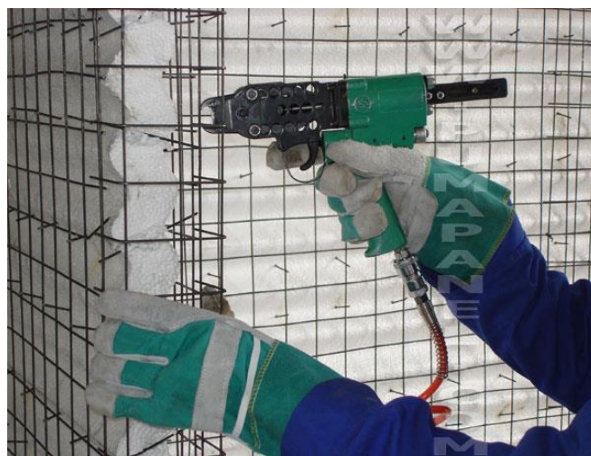
شکل ۲-۸۷: اجرای پانلهای 3D
