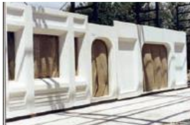
شکل ۲-۷۲: سیستم دیوارهای توپر
