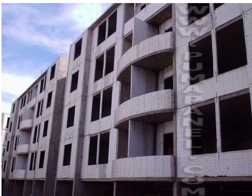
شکل ۲-۸۹: اجرای پانلهای d3 عنوان دیوارهای غیر باربر
