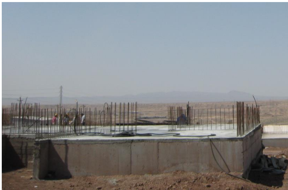
شکل ۲-۲۹: اجرای فونداسیون گسترده به همراه میلگردهای انتظار برای شروع عملیات اجرای دیوارها و سقفها به کمک سیستم قالب تونلی
