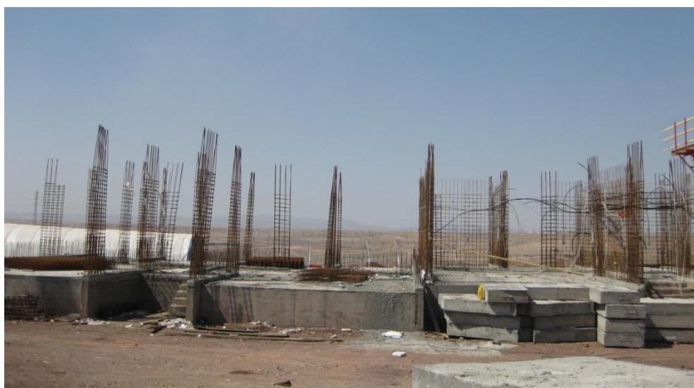
شکل ۲-۳۰: اجرای میلگرد گذاری دیوارها قبل از بستن قالبهای دیوارها در سیستم قالب تونلی
