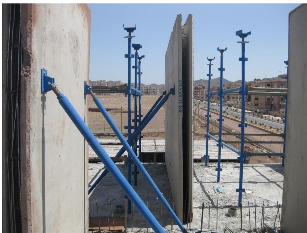
شکل ۲-۴۴: نحوه نصب قطعات نیمه پیش ساخته دیوار دولایه در کارگاه و تثبیت موقعیت آنها توسط پشت بندها
