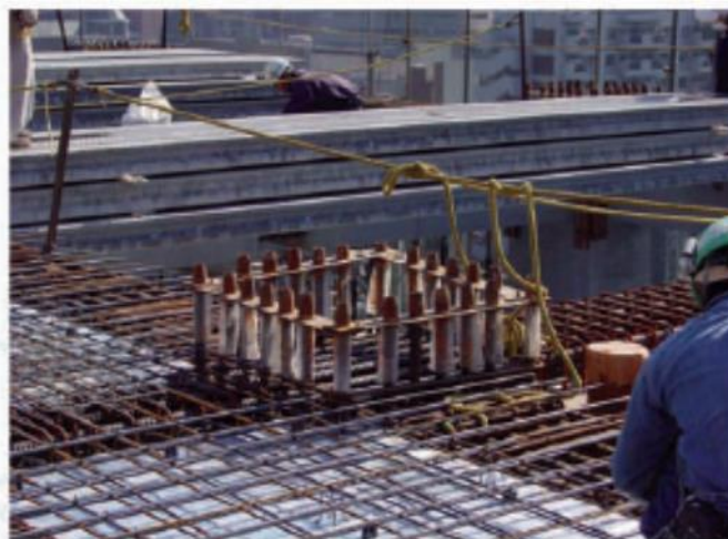
شکل ۲-۷۶: سیستم سقف در فناوری R-PC
