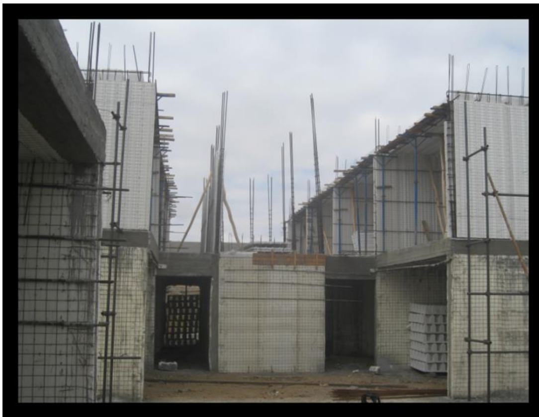
شکل ۲-۲۶: نحوه چیدمان و شمع بندی پانلهای ساندویچی سیستم RICE
