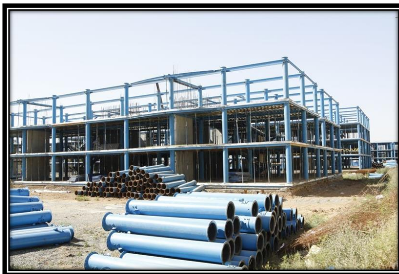
شکل ۲-۷۷: نمونه ای از سازه اجرا شده CFT
