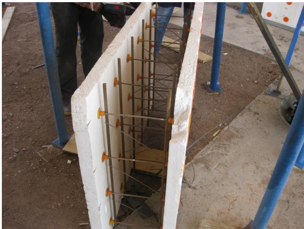
شکل ۵۱-۲: نمونه قالب عایق ماندگار به همراه میلگردهای قائم و رابطهای مهار کننده دو صفحه عایق
