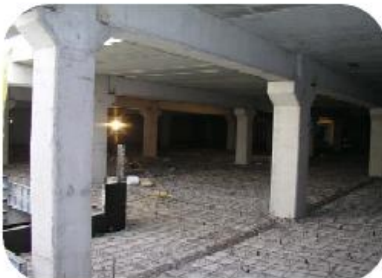
شکل ۲-۶۷: اتصال جوشی تیر نیمه پیش ساخته به کربل در ستون میانی وکناری
