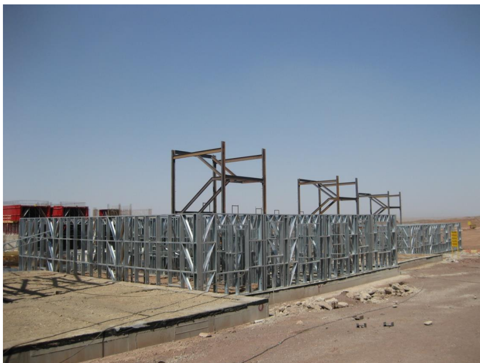
شکل ۲-۵: اجرای سازه راه پله به صورت مجزا نسبت به اجزای سازه LSF
