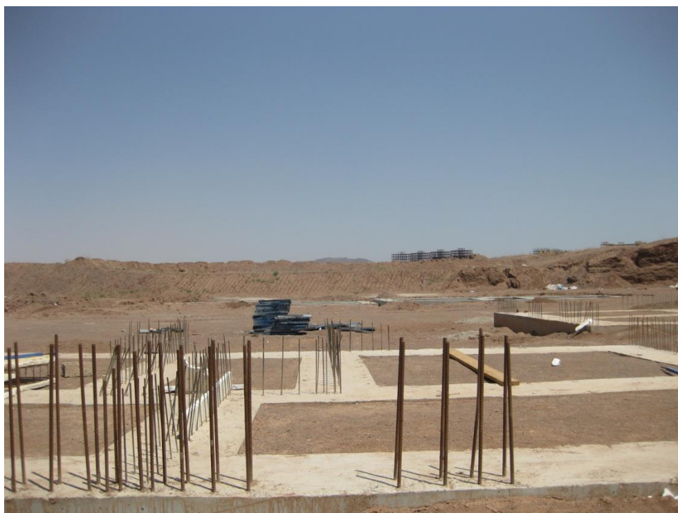
شکل ۲-۵۰: اجرای فونداسیون و آماده سازی سطح برای اجرای دیوار بتن مسلح با قالب عایق ماندگار
