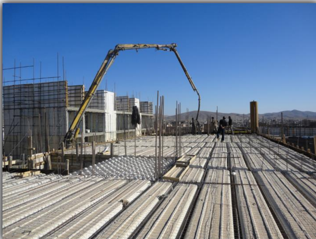
شکل ۲-۲۷: سقف سیستم RICE
