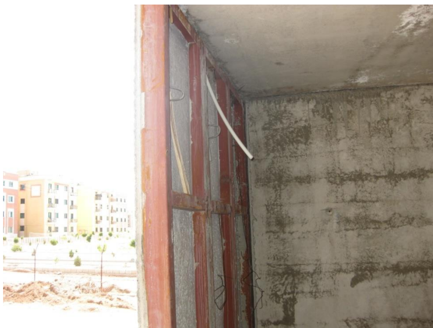
شکل ۲-۴۸: اجرای پانلهای نما به صورت نیمه پیش ساخته در کارخانه و نصب در کارگاه مربوط به سیستم نیمه پیش ساخته با دیوار دو لایه
