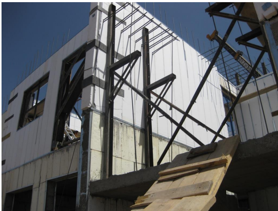
شکل ۱۱-۲: مهار سیستم V-ICF توسط پشتبندهای نگهدارنده و فراهم نمودن شرایط برای بتن ریزی
