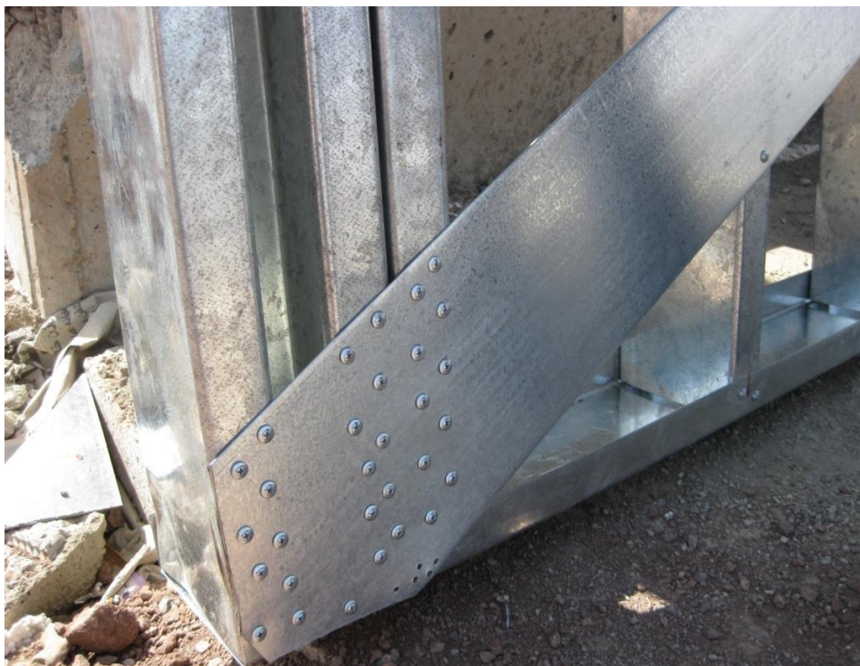
شکل ۲-۳: اجرای اتصالات در سیستم LSF به کمک پیچ
