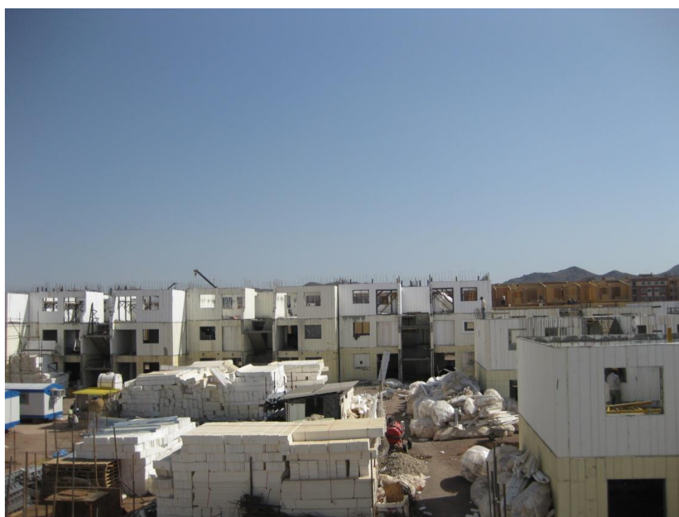
شکل ۱۰-۲: اجرای ساختمانهای ۳ طبقه با سیستم V-ICF
