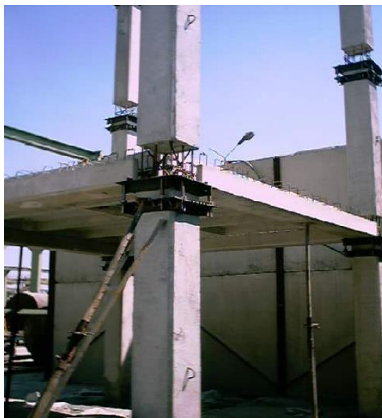
شکل ۲-۵۹: نصب تیر و ستون پیش ساخته
