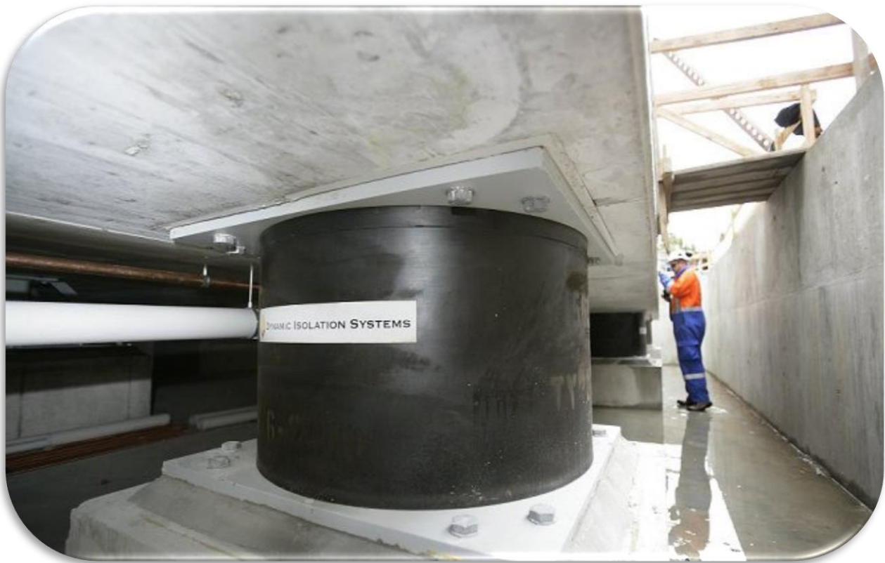
شکل ۲: نمونه ای از اجرای میراگر لاستیکی
