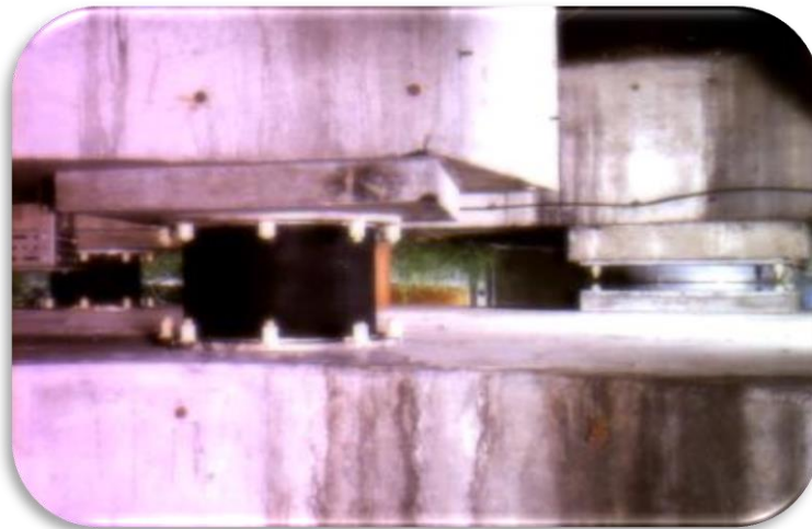
شکل ۷: سیستم ترکیبی جداساز لرزه ای اصطکاکی و لاستیکی
