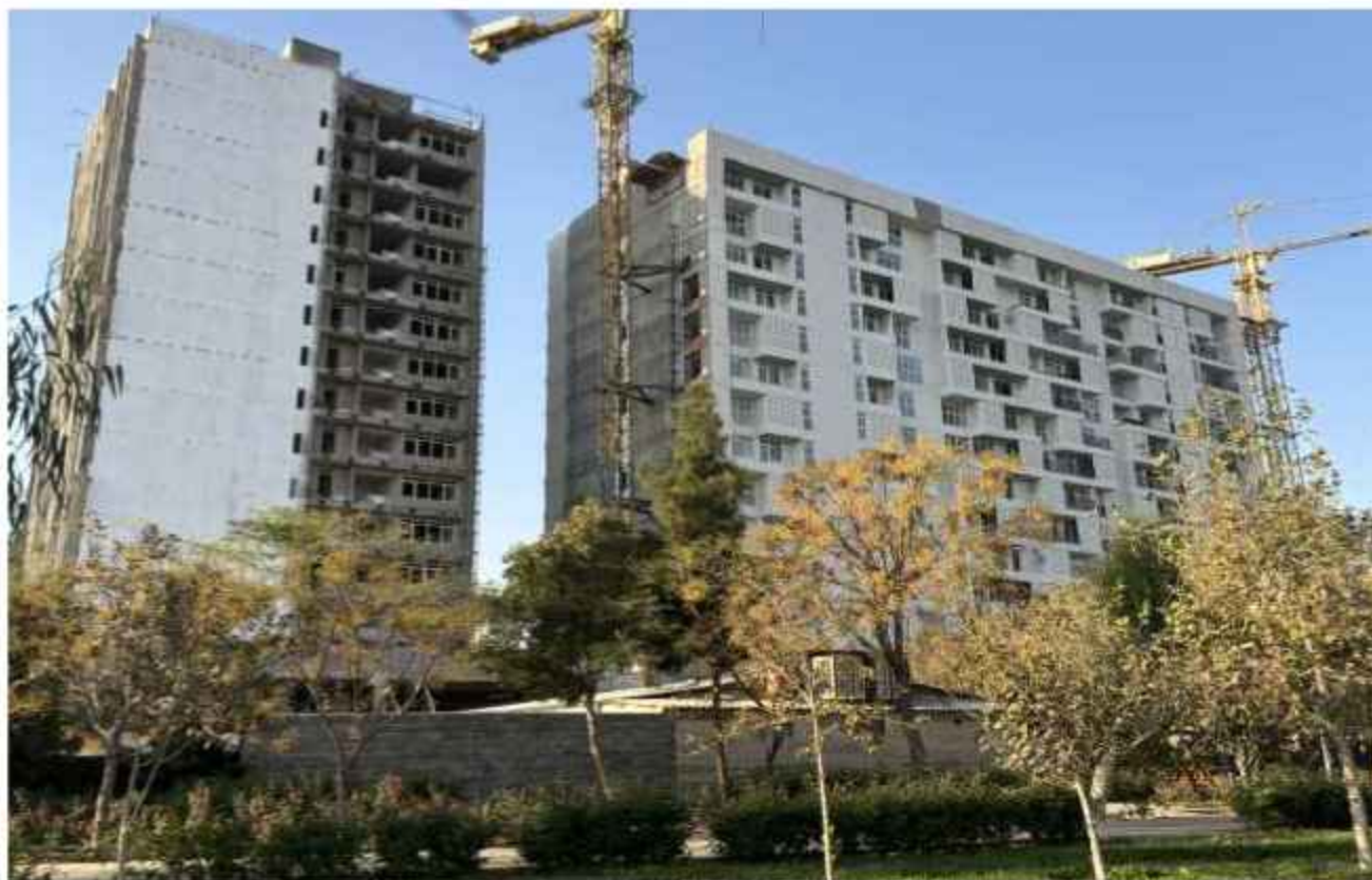
پروژه سپیدار قم
